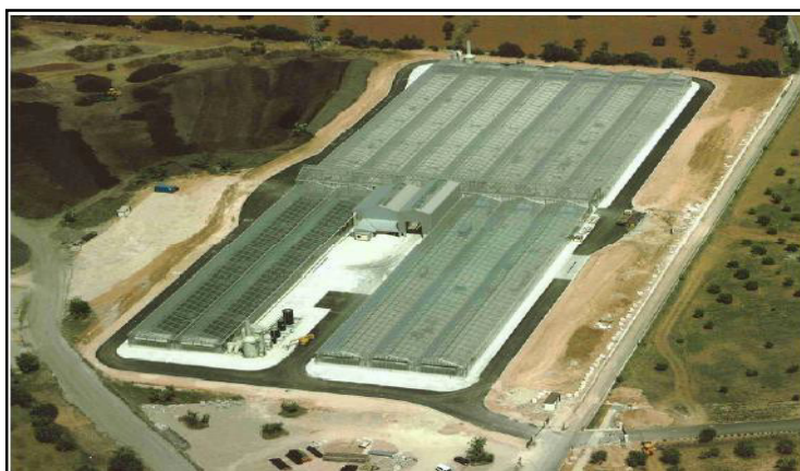
Figura 2.26 - Vista da planta de secagem solar de estufa de Palma de Maiorca na Espanha com área de 20 000 m 2
